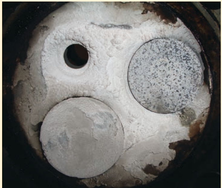
Abb. 2 Die Siliziumdioxid-Ablagerungen auf dem Zylinderkopf eines Gasmotors nach über 3.500 Betriebsstunden sind durch die Verbrennung der siliziumorganischen Spurenverbindungen im Motorraum entstanden.
